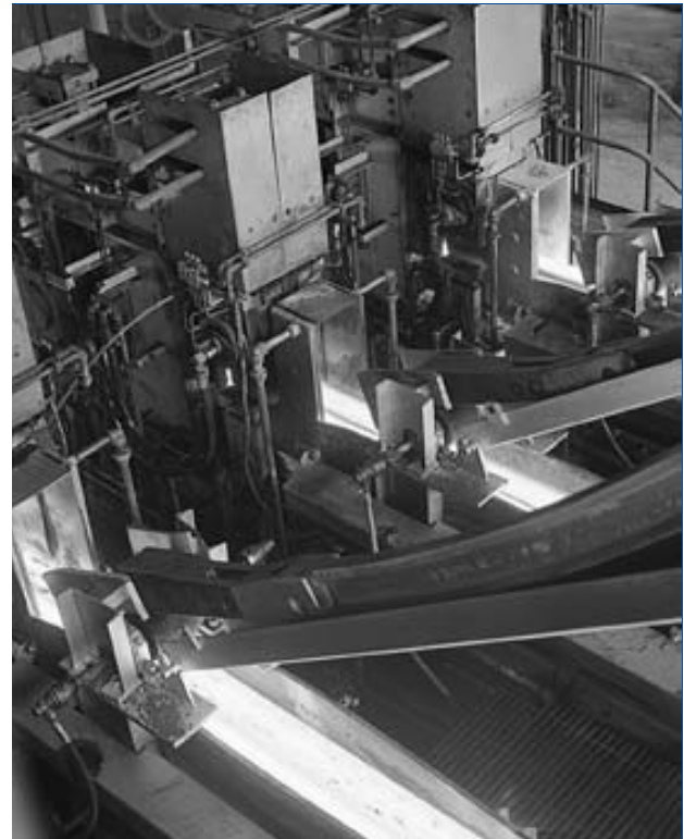
Lineas de colada continua de acería, Planta Colina, Gerdau AZA.
